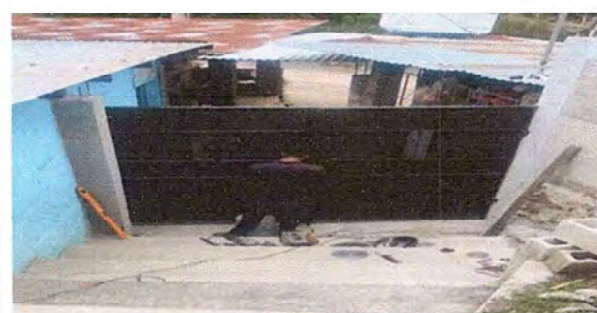
Foto 4: Portón ya instalado.
