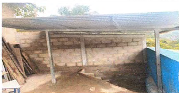
Foto 1: Muro terminado de la parte de atrás de la escuela.
