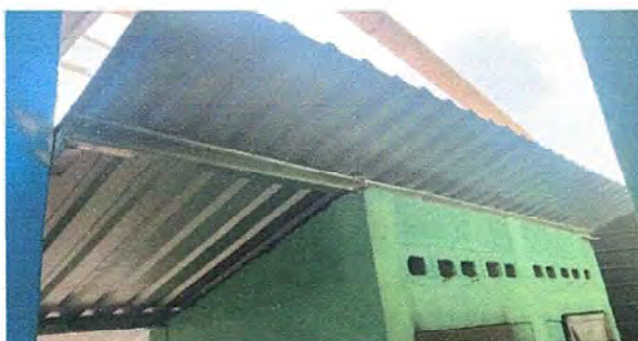
Foto 3: Baños con costanera y lámina.
