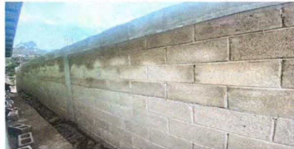
Foto 2: Muro terminado de la parte de enfrente de la escuela.
